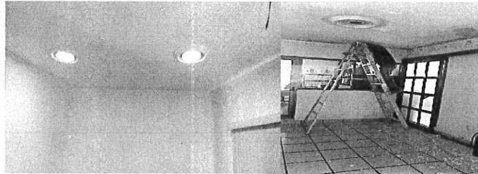
Colocación de lámparas de emergencia en oficinas centrales
