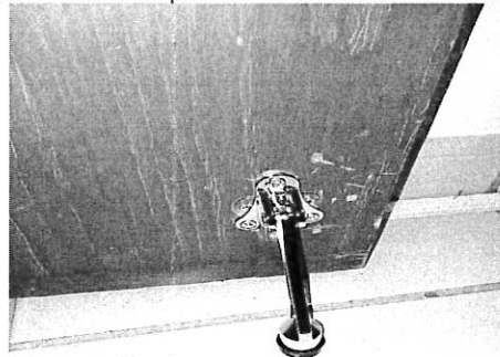
Colocación de pata de cabra en puerta de la oficina de comunicación e imagen
