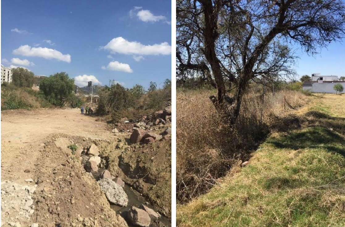
Figura 203. Puntos 5 y 6 de Riesgo por inundación 2019.
