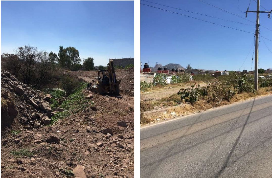
Figura 205. Puntos 9 y 10 de Riesgo por inundación 2019.
