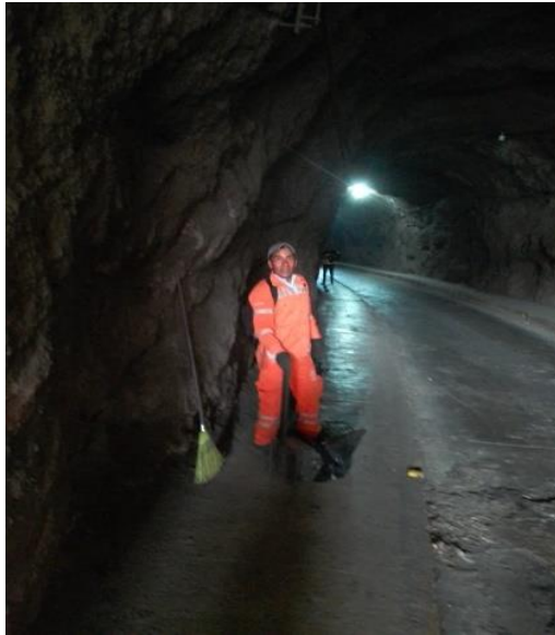
Fig.63. Barrido en túnel.
