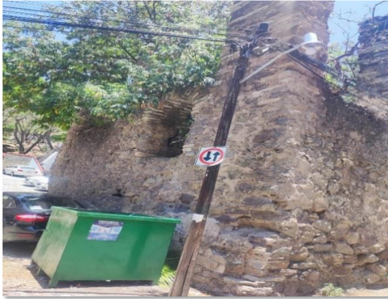
Fig. 87. Contenedor de almacenamiento temporal. Fuente: Imagen propia.
