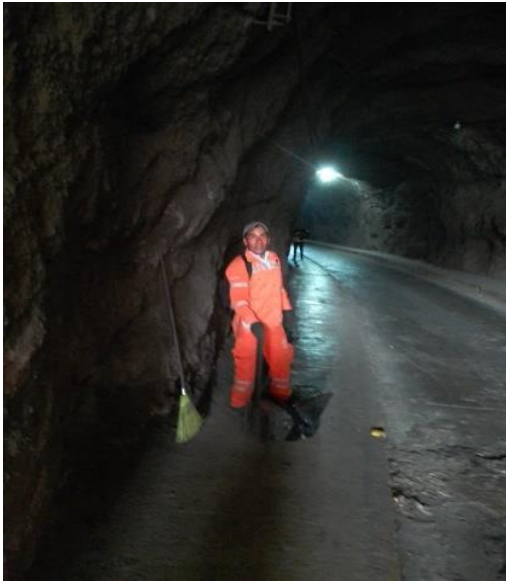
Fig.63. Barrido en túnel.
