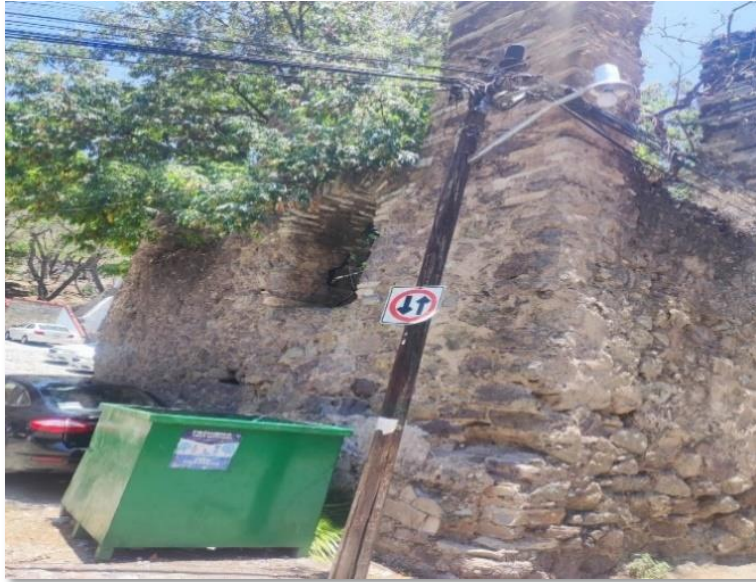
Fig. 87. Contenedor de almacenamiento temporal. Fuente: Imagen propia.
