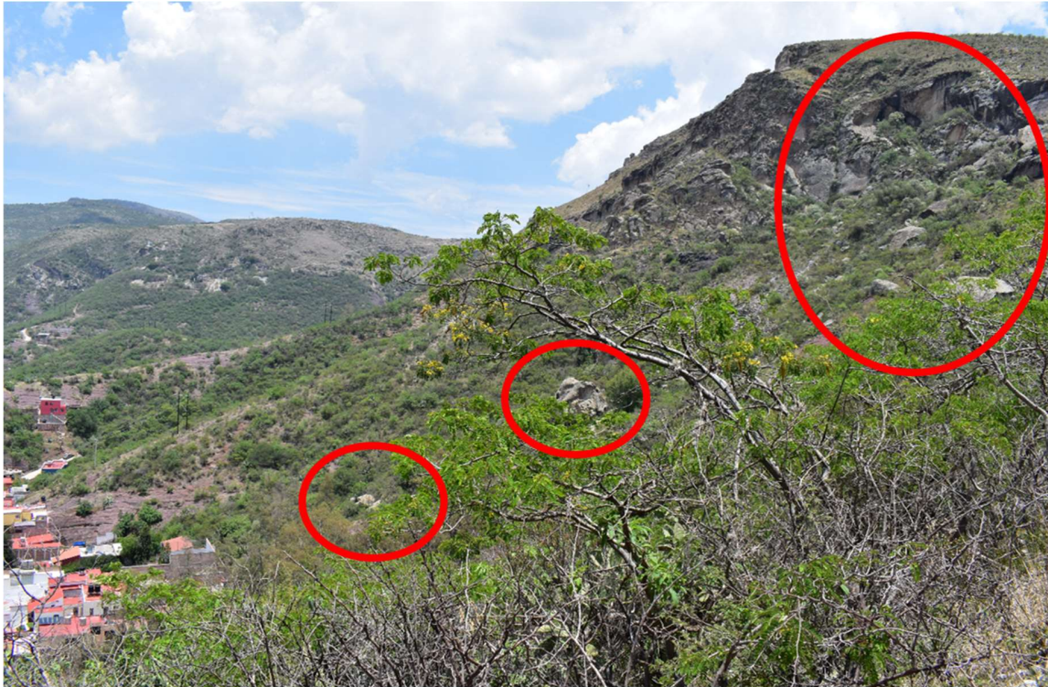
Figura 177. Desprendimiento de rocas y derrumbes al sur del Fracc. Lomas de Zaragoza. Fuente: Fotografía tomada en visita de campo, julio de 2022.
