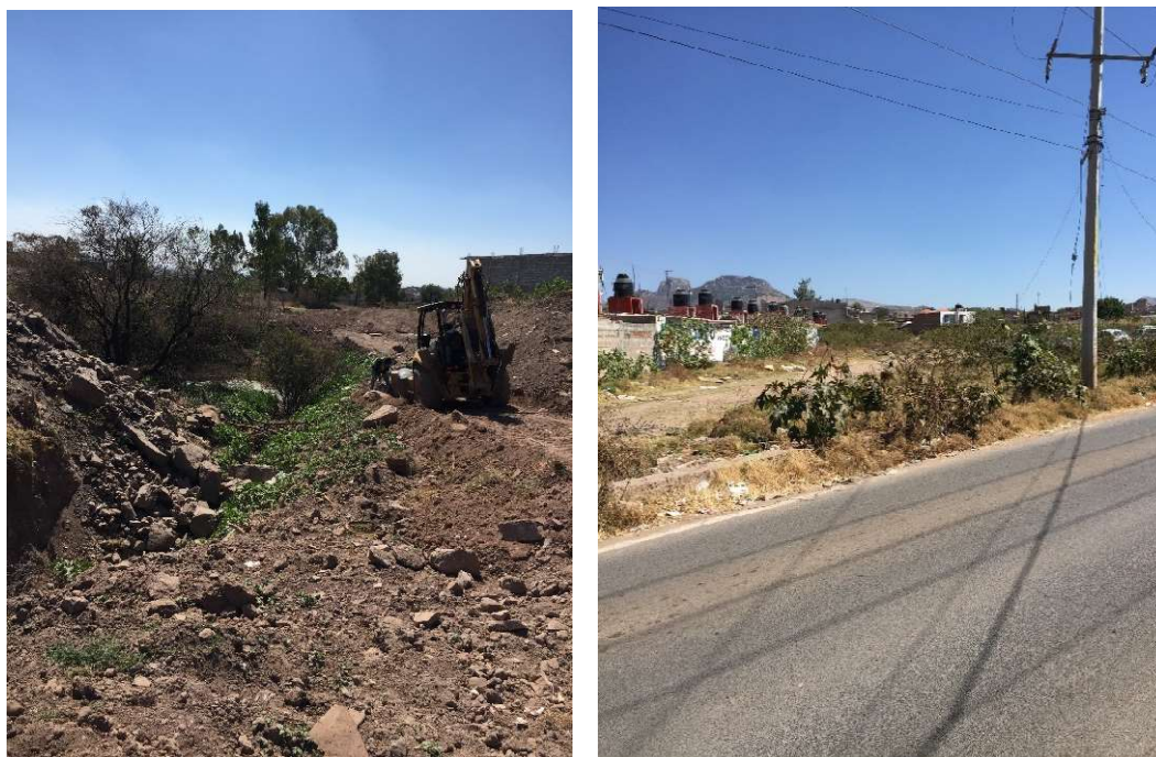
Figura 205. Puntos 9 y 10 de Riesgo por inundación 2019.
